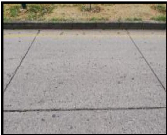
Deterioro o rompimiento del sello en juntas longitudinales y transversales que permiten entrada de materiales incompresibles o infiltración de agua. Posibles causas son extrusión del sello, pérdida de adherencia entre el sello y la losa o por crecimientos de vegetación.
