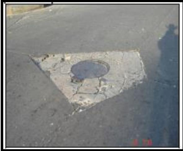
Son grietas directamente relacionadas por presencia de pozos o sumideros. Sus posibles causas son por variación en la distribución de esfuerzos o la falta de apoyo de la losa originando una erosión en la base ALABEO TERMICO, sobrecarga en la esquina. Deficiente emisión de cargas entre losas adyacentes.
