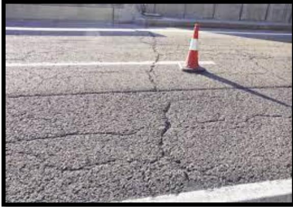
Se extiende desde la junta hasta el borde, se producen por malos asentamientos, ancho excesivo de la losa, albedo térmico, carencias de juntas, mal posicionamiento y contracción de la losa.
