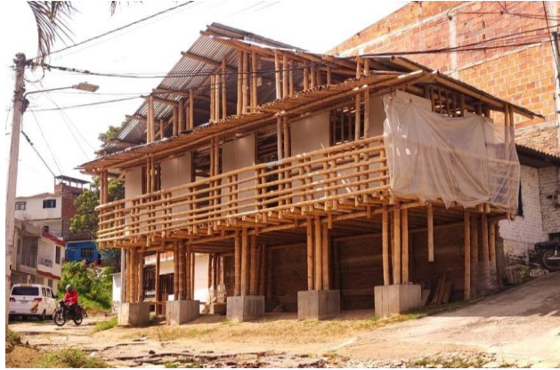
Ilustración 5, Estructura de Guadua, barrio El Bosque, Ocaña-Colombia
